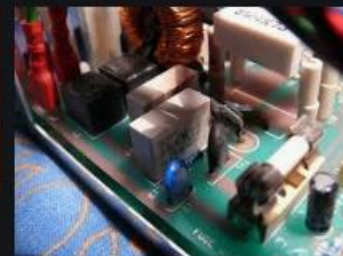
Uszkodzony prostownik w p...
